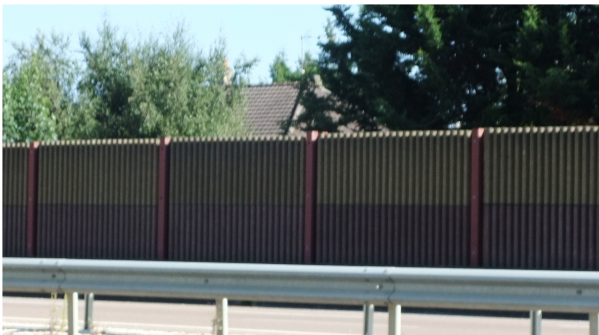
Figure 18: Écran acoustique mis en place sur la RN6 lieu dit les Chesnez
