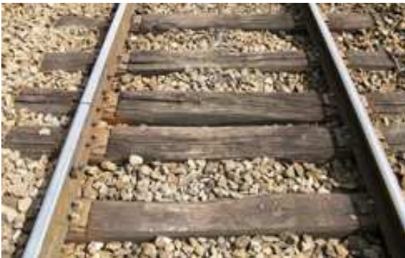
Figure 8 : Remplacement de traverses bois par des traverses bétons pour un gain de 3 dB(A) (Source RFF).
