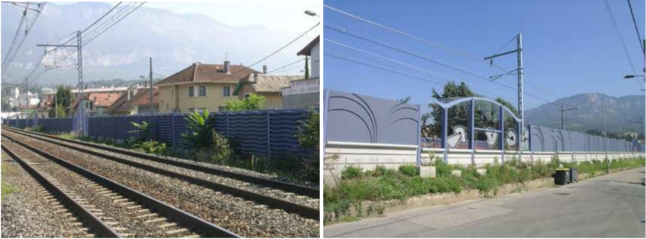
Figure 11: Exemples d'écrans acoustiques à Aix-les-Bains (Source RFF).
