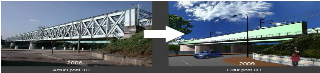
Figure 9: Exemple de changement de pont métallique à Oissel (Source RFF).
